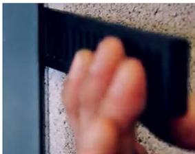
9. Calce la base del marco, manteniendo el lado de las bisagras pegado al muro y agregando calzas del lado de la cerradura para apretar la tabla separadora. Si más de  $\frac{1}{4}$ " de calzas es necesario, divida las calzas necesarias entre ambas jambas. Asegúrese de que los 4 rebajes (rabbets) del marco toquen la tabla separadora. Esto prevendrá que el marco se tuerza.
