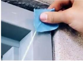
13. Pegue hilos con cinta diagonalmente en esquinas contrarias de la cara del marco para confirmar que está bien alineado. Mantenga la cinta pegada hasta que se haya completado la instalación del marco.
