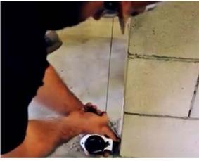
6. Haga una marca en la parte superior e inferior del muro. Trace una línea con gis entre ambas marcas. Acomode el marco en la abertura utilizando la línea de gis como referencia.
