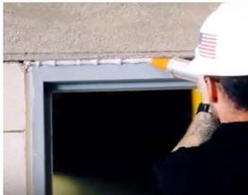
15. Remueva la cinta y la tabla separadora. Rellene cualquier orificio que exista entre el marco y el muro con silicón o con cordón de respaldo (backer road). La instalación de su marco está completa y lista para la siguiente fase de la construcción.
