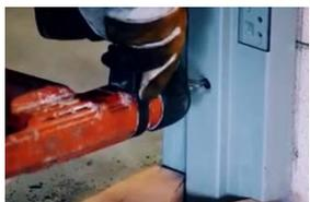
11. Determine el tamaño del agujero necesario para el anclaje, de acuerdo a las instrucciones de instalación o las especificaciones del Proyecto. Se recomienda taladrar un agujero e instalar un anclaje por vez. Empiece con el anclaje de piso en la jamba de bisagra. Taladre e instale el anclaje. Asegúrese de verificar que la jamba este a plomo y nivelada, después apriete el tornillo de acuerdo a las recomendaciones del fabricante.
