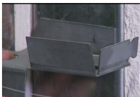
Steel stud anchor
